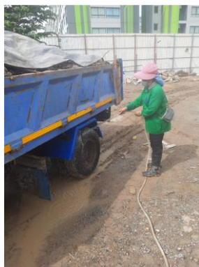
รูปที่ 8 การล้างทำความสะอาดล้อรถบรรทุก
