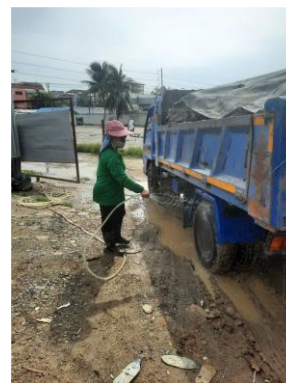
รูปที่ 8 การล้างทำความสะอาดล้อรถบรรทุก
