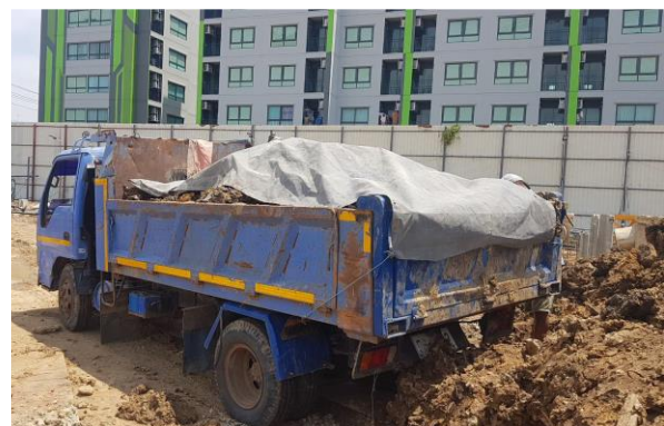
รูปที่ 5 การปิดคลุมรถบรรทุกขนส่ง
